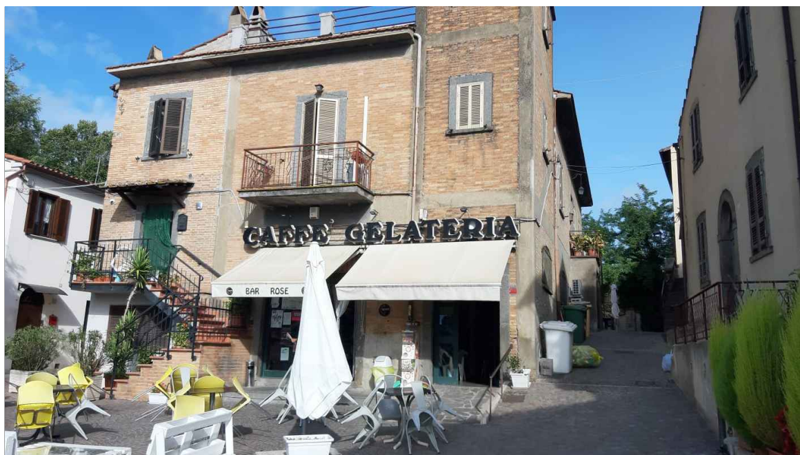
foto 1 - vista esterna del locale commerciale oggetto di Esecuzione.
